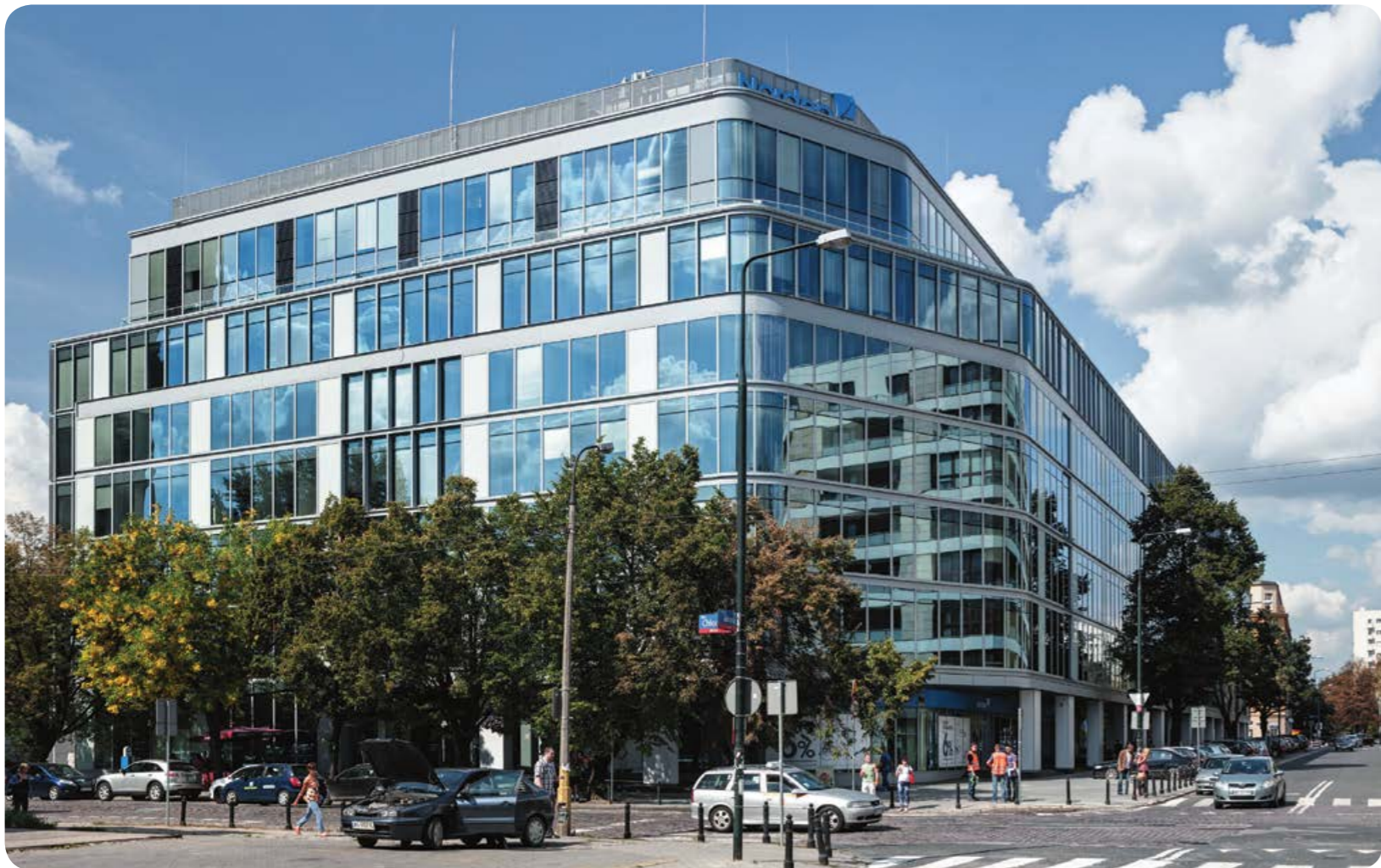
Green Corner w Warszawie Green Corner in Warsaw · Офисное здание Green Corner в Варшаве
